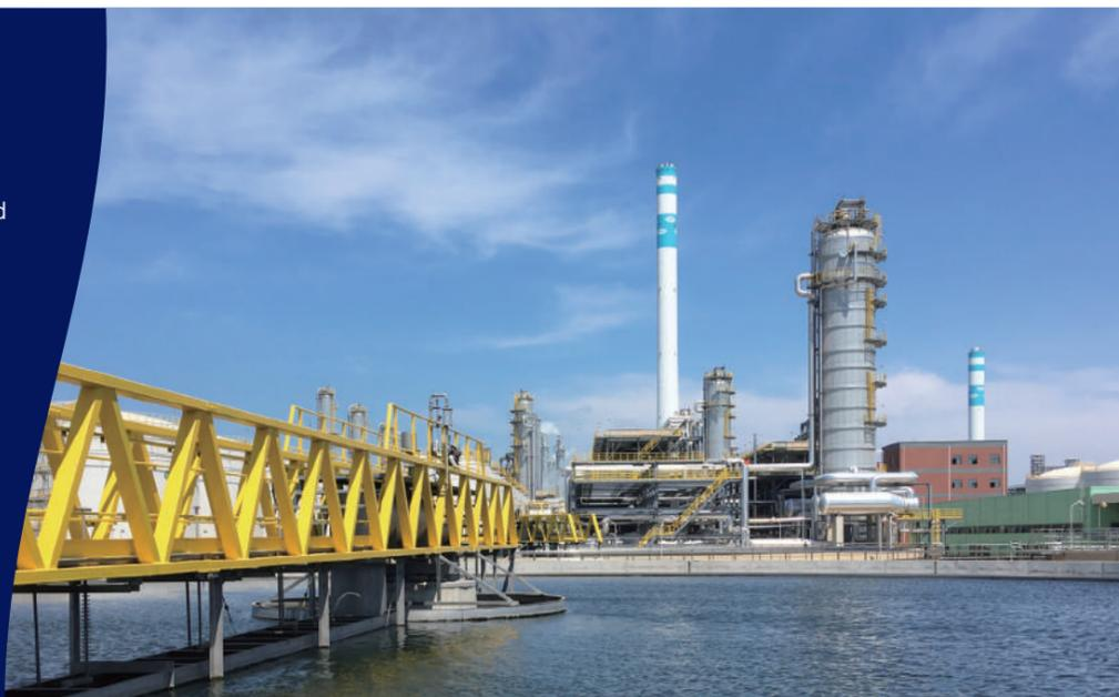
恒力石化（大连）2000万吨/年炼化一体化项目，建有国内规模最大的煤制氢气化装置，氢气产量可达到50万标方每小时，生产的氢气主要用于炼化生产中。
