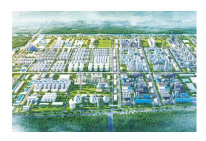
苏伊士为盛虹炼化位于连云港徐圩石化产业园处理规模为7.92 万立方米/日的污水处理厂提供工艺设计设备供货以及技术服务。项目采用创新的嵌入式污水处理厂的设计理念,从设计之初把污水处理工艺和石化工艺充分结合形成整体,将本该当作废弃物处置的"水、气、渣"作为可利用的资源,回用在污水处理流程中,以"废"制"废",实现变废为宝。除了可以大量节省运营成本外,每年减少碳排放8.123 吨。
