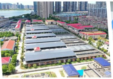
苏伊士与湖南鑫远环境科技股份有限公司 签订协议,为长沙开福污水处理厂提供 AQUADVANCED<sup>®</sup>智慧厂区管理系统,提升 污水处理厂绩效。项目处理规模达到25万立 方米/日,出水达到地表水准四类标准。苏 伊士将提供一套精确曝气系统,并承诺比使 用设备前节能7%。
