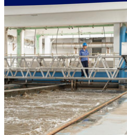
苏伊士为常熟经济技术开发区工业污水处理厂提供深度处理系统，包括 Densadeg<sup>®</sup> 高密度沉淀池、Aquazur V 型滤池和活性炭吸附单元工艺设备供货及相关技术服务，使污水达标排放，保障企业稳定运行，提升园区的竞争力。
