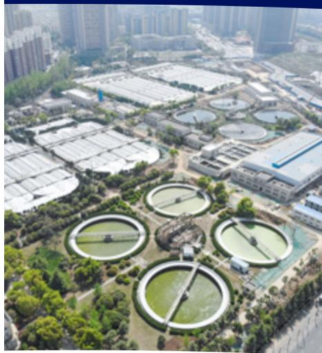
苏伊士为湖南衡阳市江东污水处理厂提供 Densadeg<sup>®</sup> 高密度沉淀池以及配套自控系统的设备供货及技术服务，以提升出水水质，稳定达标排放到当地河道，保护历史文化名城的水环境。
