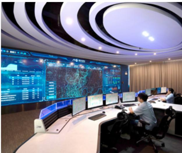
由重庆中法供水研发的“自来水厂需水量预测软件”获得国家版权局计算机软件著作权。此系统主要把气象数据、需水量历史数据、特殊日期标签等水量相关数据和本地调度经验关联结合，通过机器学习预测未来24小时的需水量。自2022年5月投用以来，预测数据与实际数据的平均误差仅有4.8%。
