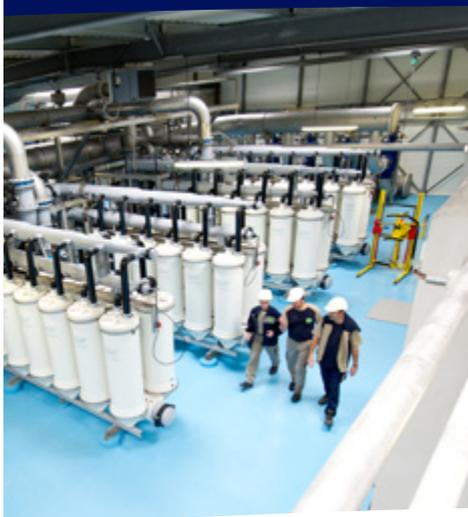
为江苏省苏州市工业园区礼来苏州制药有限公司污水处理厂提供预处理系统、反渗透脱盐系统、浓水蒸发和干燥固化系统以及产水混床深度脱盐系统，以去除氮、磷实现零排放。每年为客户减排约 15 吨的磷，减少约 230 吨固废产量。
