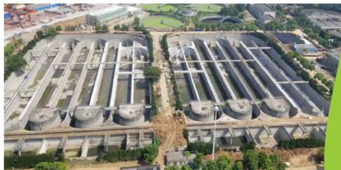
改造前，该污水厂的处理规模为 18 万吨 / 日，分为两个阶段建成。第一阶段工程规模为 8 万吨 / 日，第二阶段工程规模为 10 万吨 / 日，服务覆盖面积约为 66 平方公里。该项目采用氧化塘 + 二沉池 + V 型滤池的工艺，出水执行 GB18918-2002 一级 A 标准，尾水排入南淝河。
