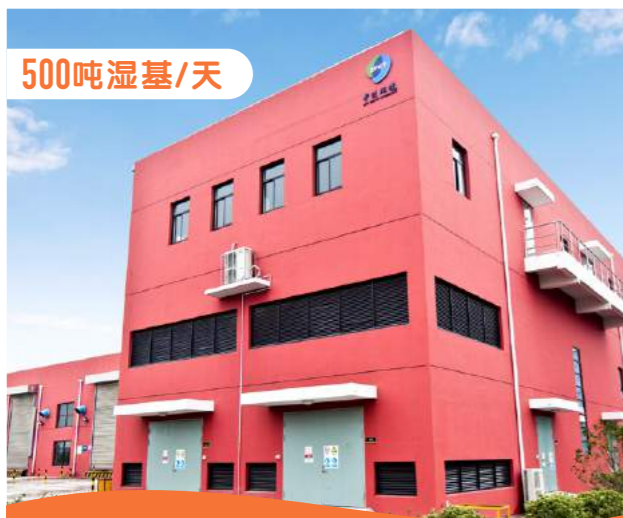
苏州工业园区 污泥处置与资源化项目
