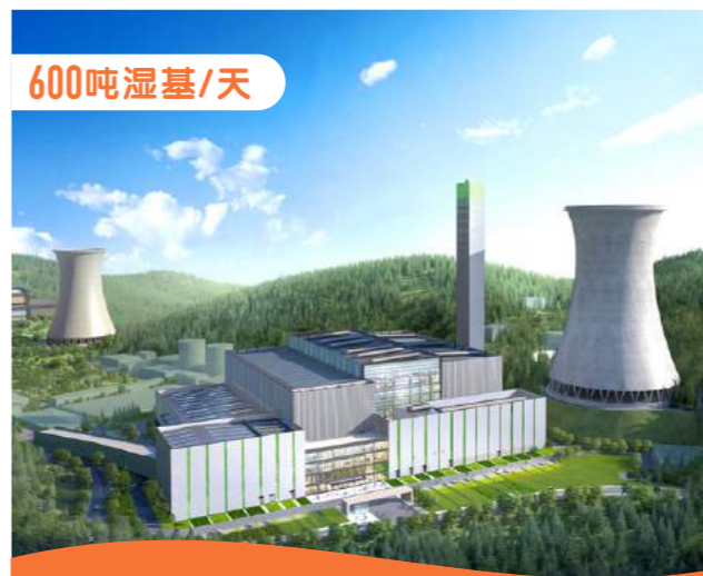
长沙污泥处理处置项目二期
