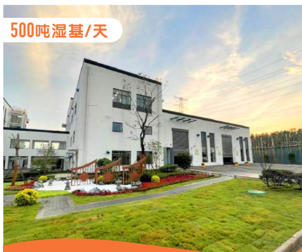
扬州污泥干化处置项目
